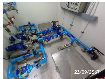
ถังเก็บน้ำ และ Transfer Pump ชั้นใต้ดิน
