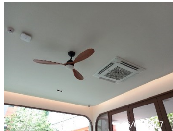
เครื่องปรับอากาศ และพัดลมระบายอากาศ
